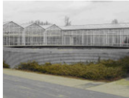
Waterbassin voor opslag regenwater bij serre
